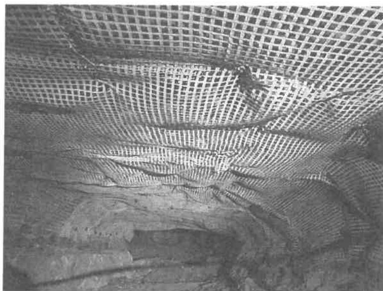
Zdjęcie 1 Wyrobisko osiatkowane siatką MiMesh
