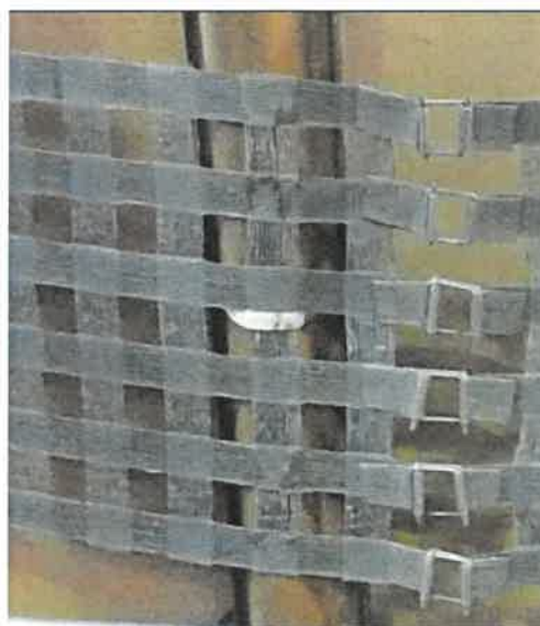
Rys. 4.3.3. Zaciski klamrowe na przedłużeniu siatki dla zapewnienia ciągłości
