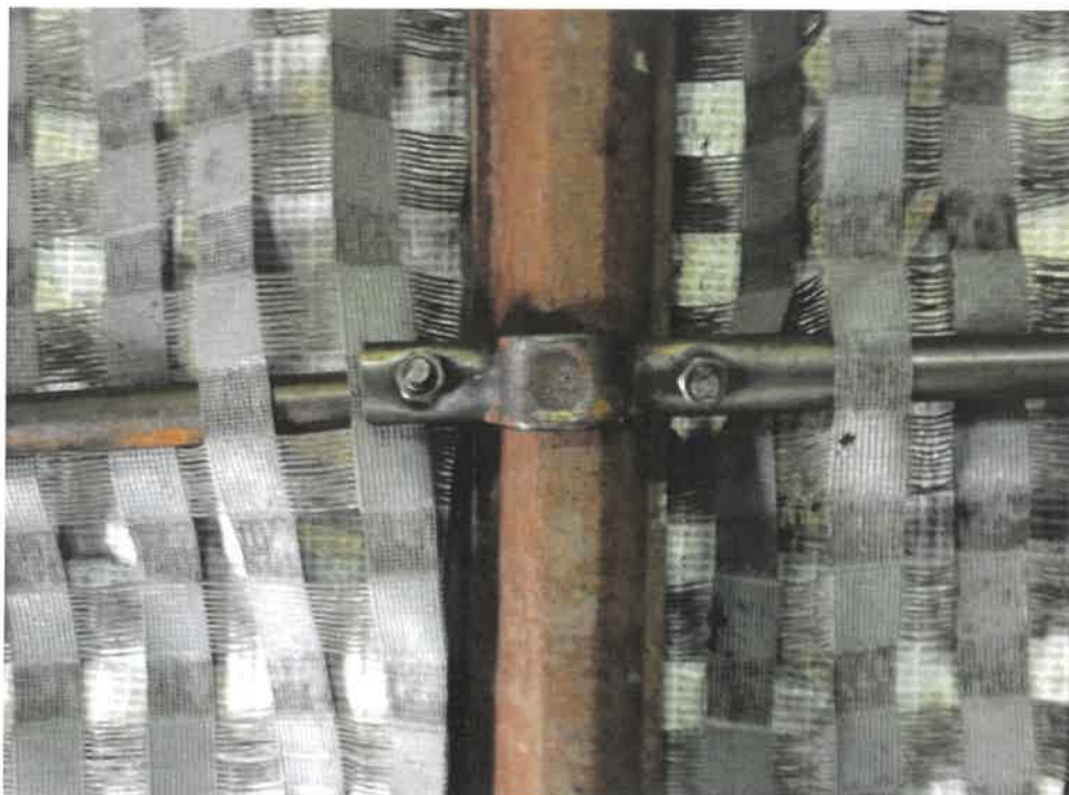
Rys. 4.3.16. Sposób mocowania siatki założonej za odrzwiami obudowy za pomocą rozpór przeplecionych przez siatkę
