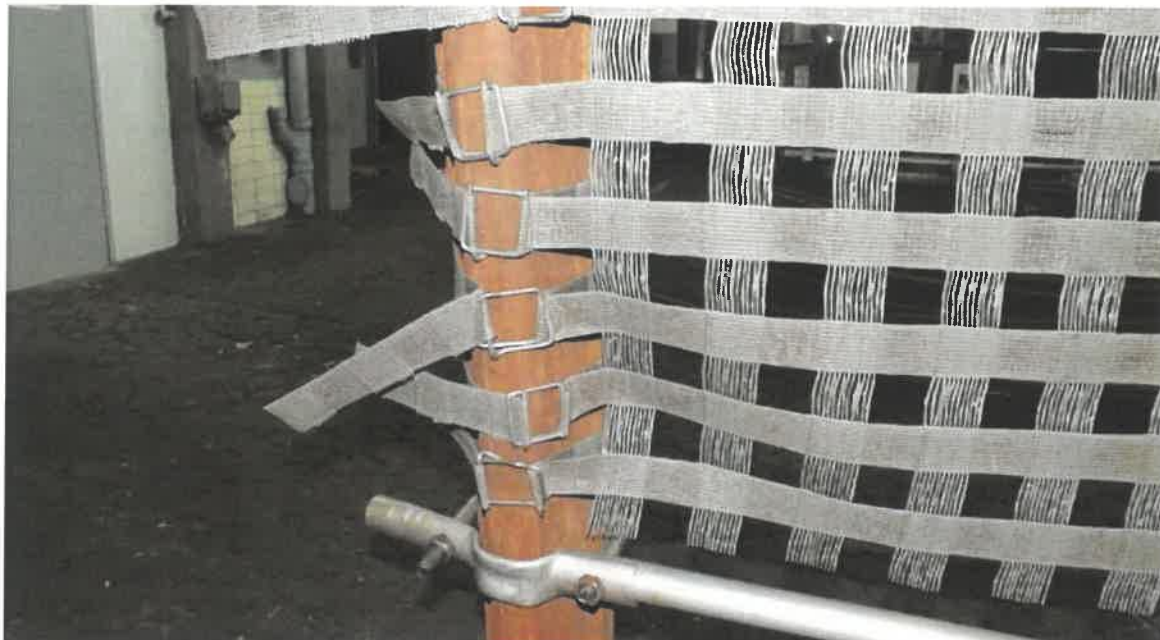
Rys. 4.1.3. Zamocowanie pasów podłużnych siatki POLLUX2 do kształtownika odrzwi obudowy za pomocą klamry samozaciskowej
