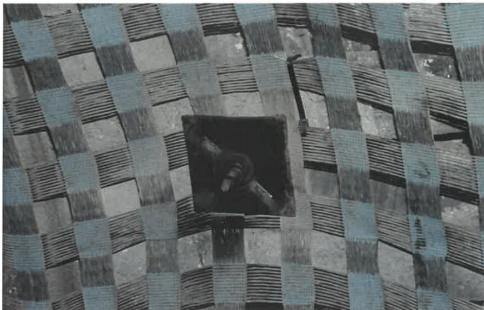
Rys. 4.2.4. Wykorzystanie siatki bazaltowej typu POLLUX2 do zabezpieczenia skorodowanej obudowy chodnikowej
