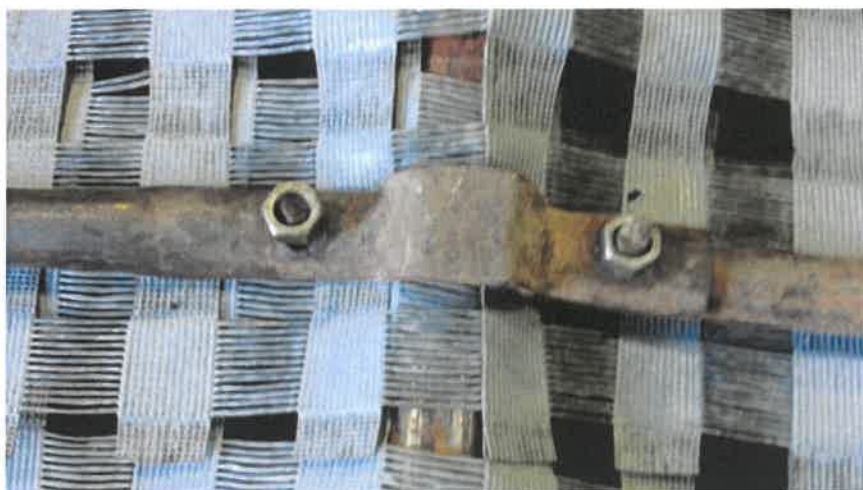
Rys. 4.3.19. Sposób mocowania siatki założonej na odrzwia obudowy za pomocą rozpór.
