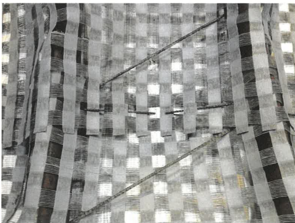
Rys. 4.3.11. Sposób mocowania siatki założonej na odrzwia obudowy za pomocą długich prętów bazaltowych o Ø14mm ułożonych ukośnie
