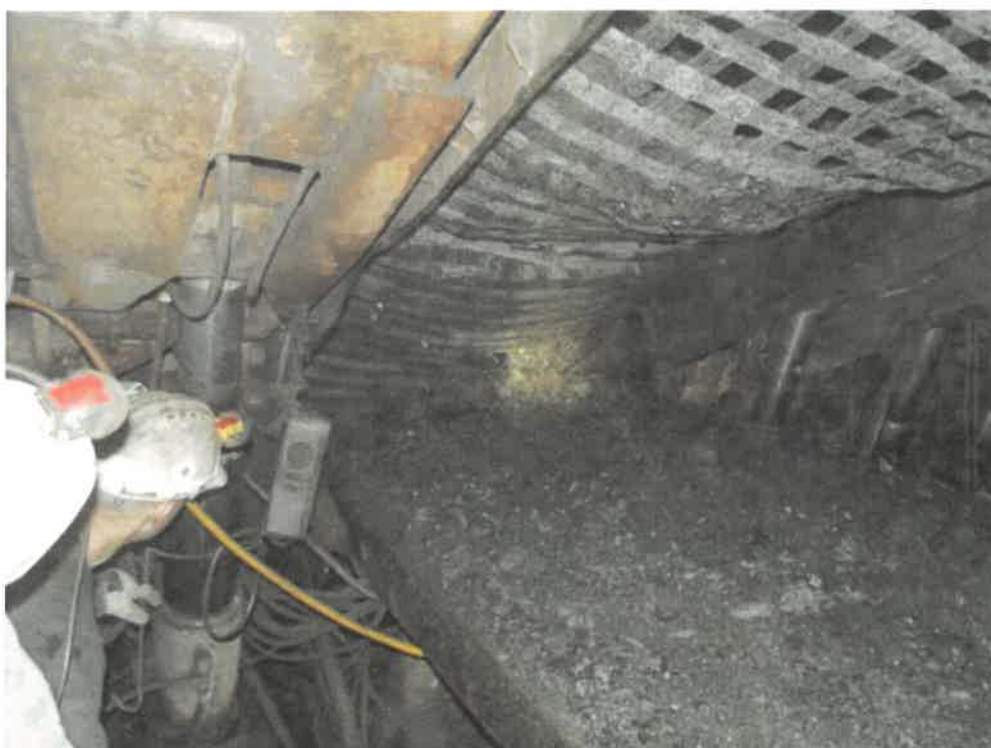
Rys. 4.5.4. Przygotowanie ściany do likwidacji z zastosowaniem siatki bazaltowej typu POLLUX2 .
