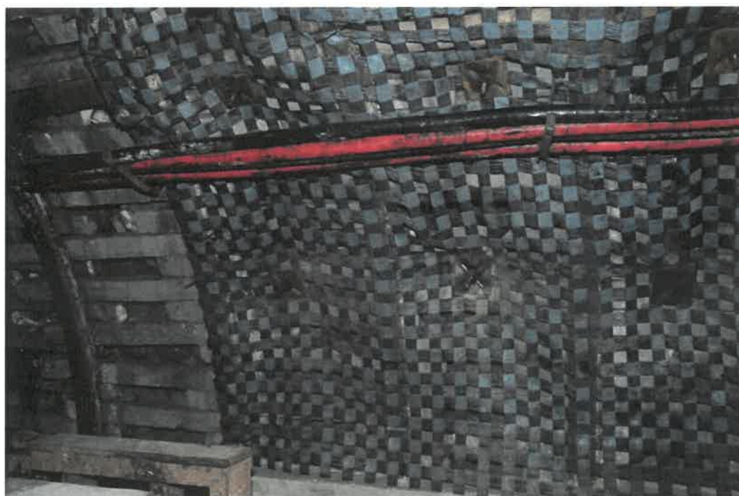
Rys. 4.2.5. Wykorzystanie siatki bazaltowej typu POLLUX2 do zabezpieczenia skorodowanej obudowy chodnikowej.
