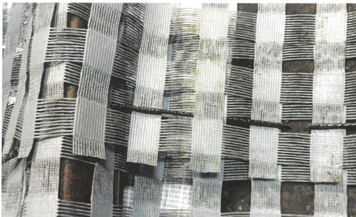
Rys. 4.4.3. Łączenie ze sobą siatki bazaltowej za pomocą prętów bazaltowych o min Ø8mm
