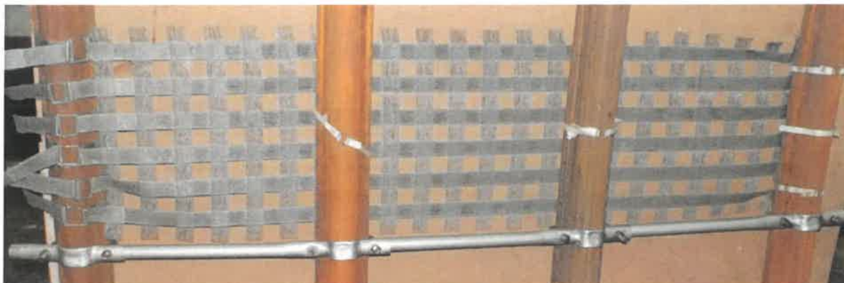
Rys. 4.1.5. Zabudowana siatka POLLUX2 na odrzwiach z naciąganiem wstępnym uzyskanym na paskach podłużnych z mocowaniem do kształtownika na długości siatki pasków poprzecznych za pomocą taśmy z klamrami (zapinkami) samozaciskowymi
