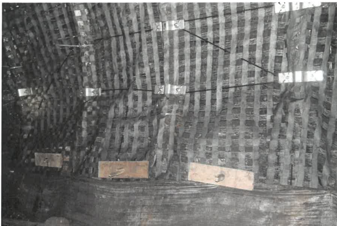
Rys. 4.3.22. Mocowanie siaki za pomocą kotew drewnianych, obejm metalowych i prętów bazaltowych o Ø14mm
