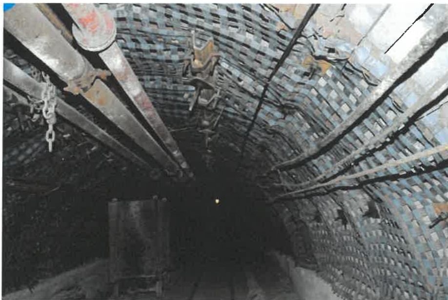
Rys. 4.2.2. Wykorzystanie siatki bazaltowej typu POLLUX2 do zabezpieczenia skorodowanej obudowy chodnikowej.
