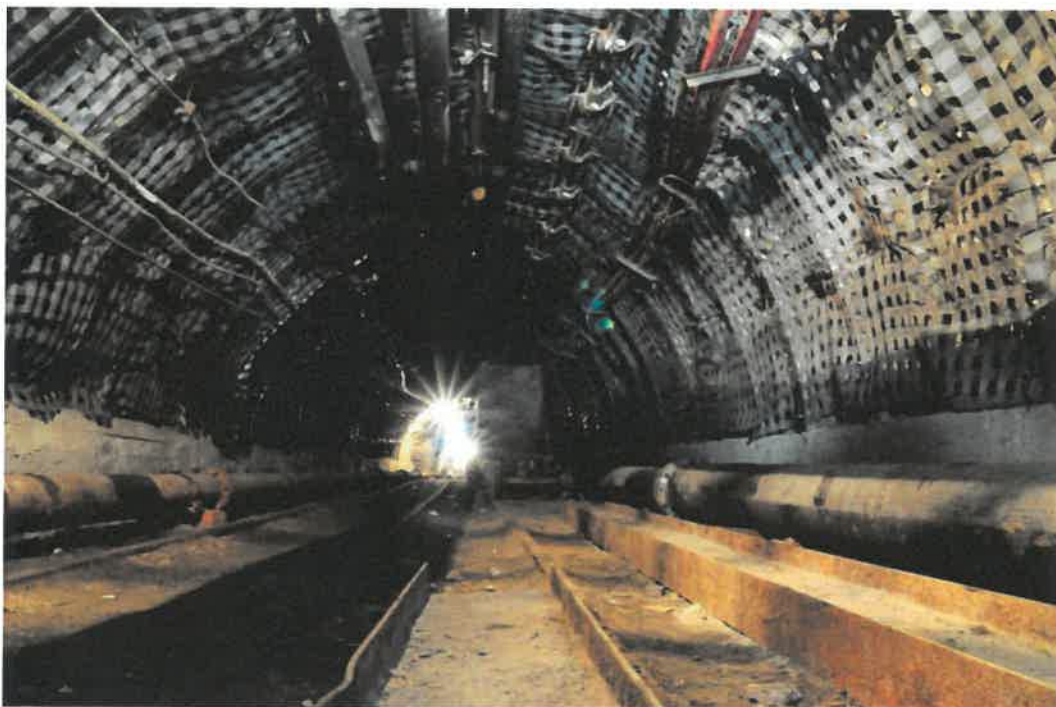
Rys. 4.2.7. Wykorzystanie siatki bazaltowej typu POLLUX2 do zabezpieczenia skorodowanej obudowy chodnikowej.
