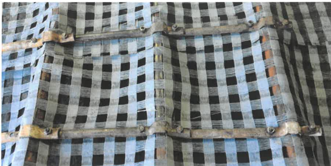
Rys. 4.3.18. Sposób mocowania siatki założonej na odrzwia obudowy za pomocą rozpór.
