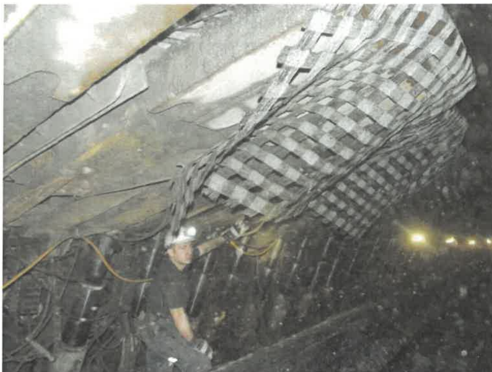
Rys. 4.5.3. Przygotowanie ściany do likwidacji z zastosowaniem siatki bazaltowej typu POLLUX2.
