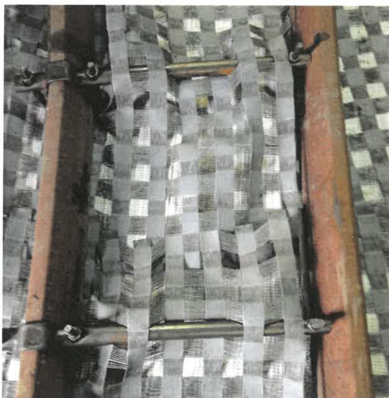
Rys. 4.3.17. Sposób mocowania siatki założonej za odrzwiami obudowy za pomocą rozpór przeplecionych przez siatkę
