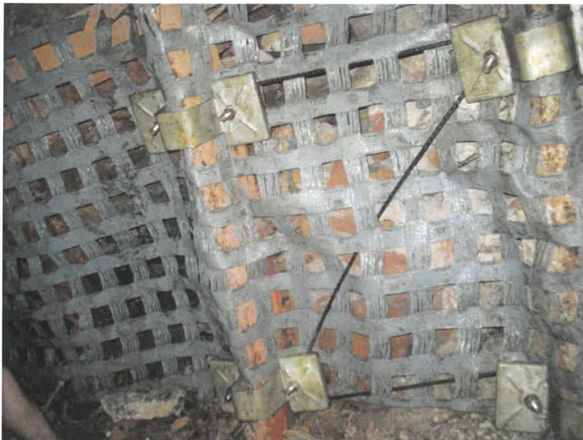
Rys. 4.3.6. Sposób zamocowania siatki za pomocą uchwytów zaciskowych i prętów bazaltowych o \varnothing 14\text{mm}
