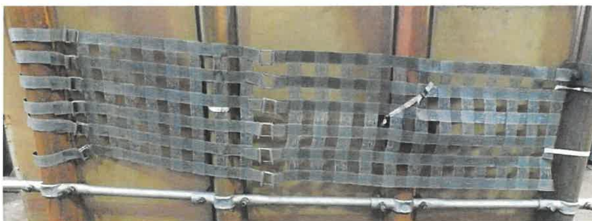
Rys. 4.3.1. Siatka naprawcza nałożona na odrzwia obudowy od strony wewnętrznej
