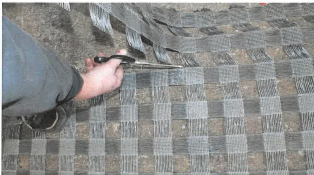
Rys. 4.1.1. Obcinanie nożyczkami pasków poprzecznych
