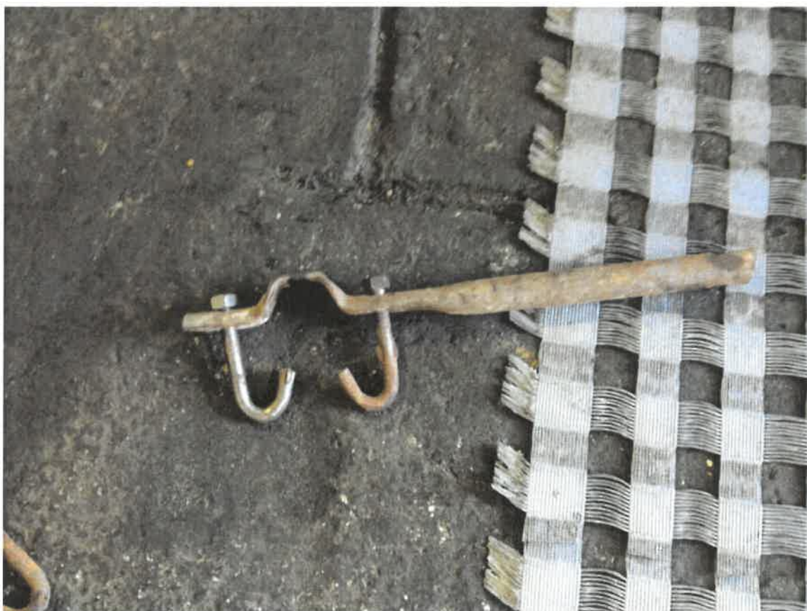
Rys. 4.3.15. Rozpora do mocowania siatki
