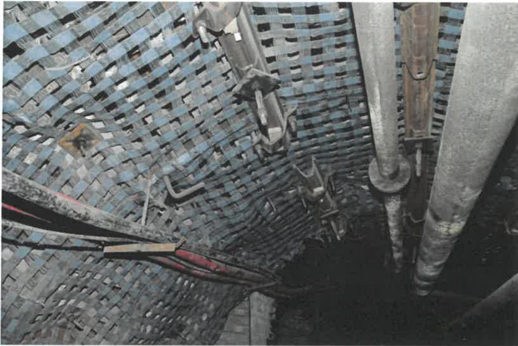
Rys. 4.2.6. Wykorzystanie siatki bazaltowej typu POLLUX2 do zabezpieczenia skorodowanej obudowy chodnikowej.
