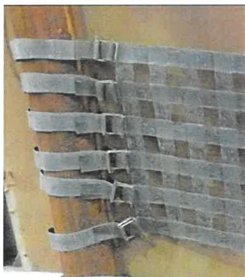
Rys. 4.3.2. Zaciski klamrowe na pierwszych odrzwiach mocowane do pasków podłużnych siatki
