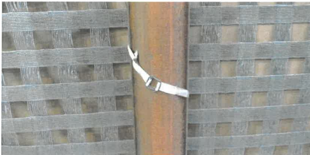
Rys. 4.1.7. Samozaciskowa klamra (zapinka) z taśmą spinającą łącząca paski poprzeczne do odrzwi obudowy
