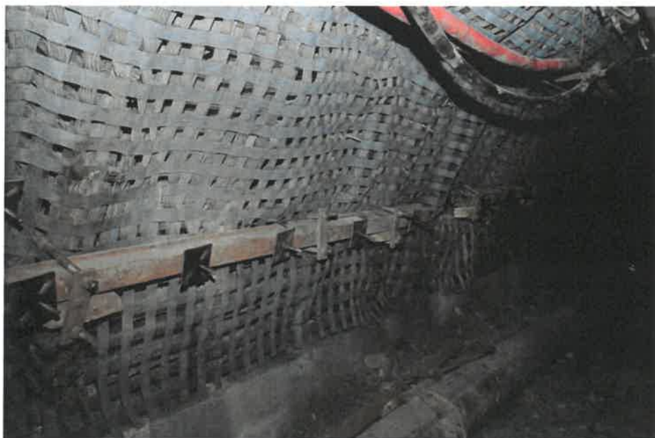
Rys. 4.2.3 Wykorzystanie siatki bazaltowej typu POLLUX2 do zabezpieczenia skorodowanej obudowy chodnikowej.
