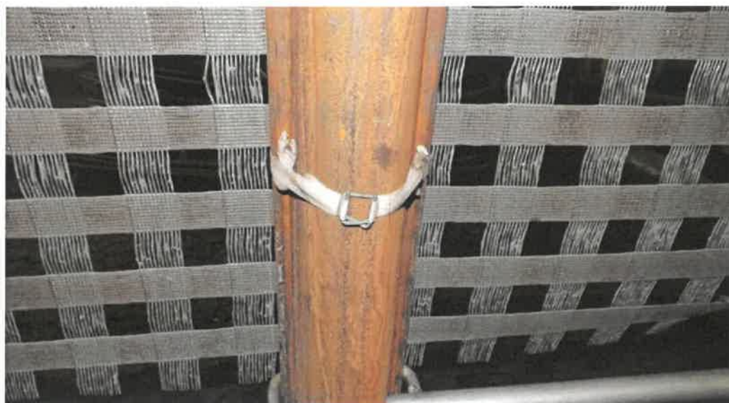
Rys. 4.1.6. Samozaciskowa klamra (zapinka) z taśmą spinającą łącząca paski poprzeczne do odrzwi obudowy
